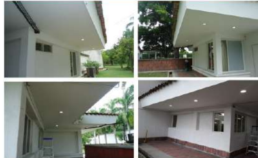
PINTURA DEL SAM Y DEMARCACION DE AREAS
